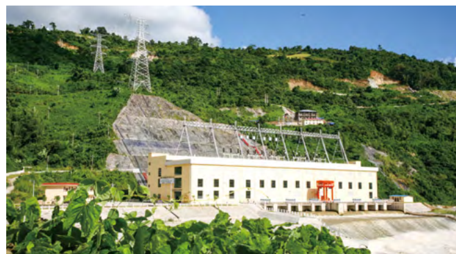
缅甸瑞丽江一级水电站
