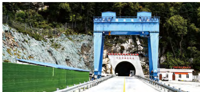
多雄拉隧道入口
