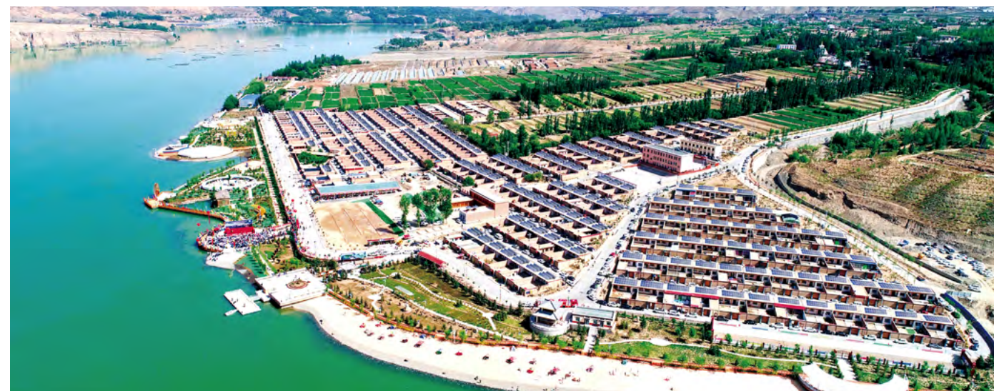
德吉村易地搬迁点屋顶分布式光伏项目
