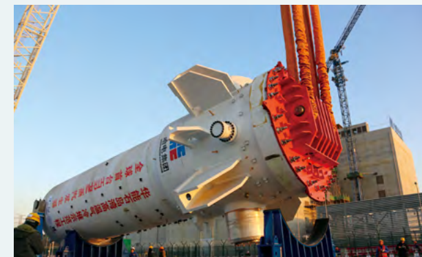
首台蒸汽发生器吊装就位
