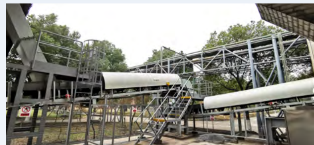
苏州热电污泥发电项目
