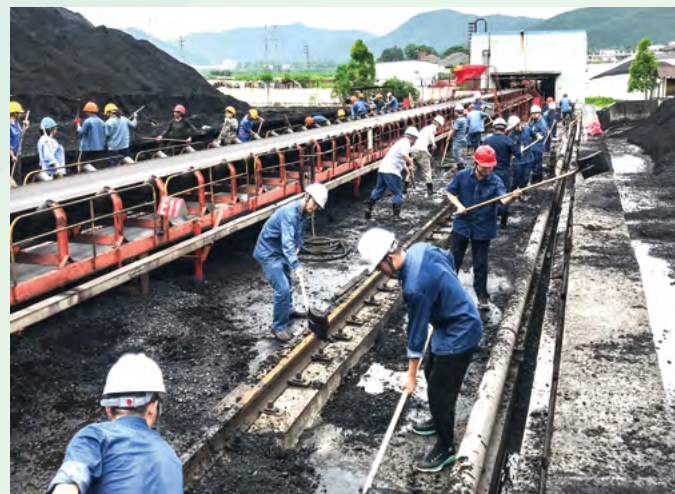
井冈山电厂对煤场进行清理加固
