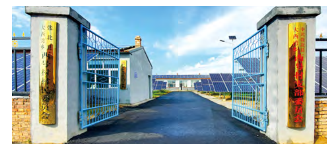
张北县西号村分布式光伏发电项目
