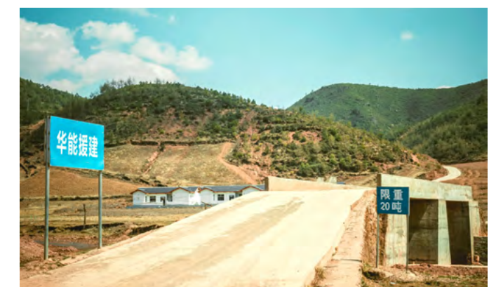
昭觉县团结村安全行桥
