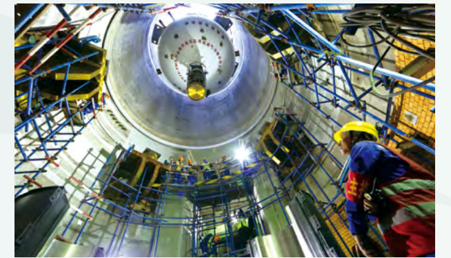
首台反应堆压力容器吊装就位
