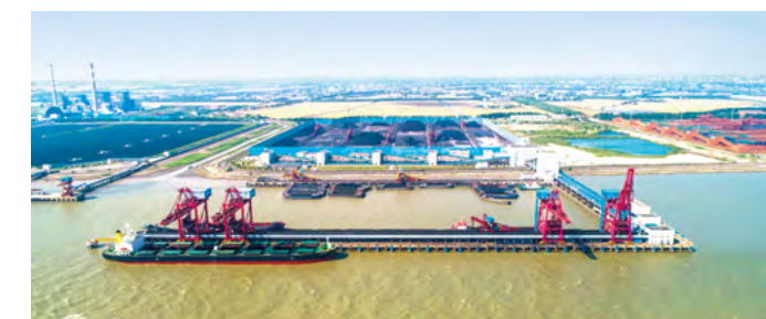
苏州港太仓港区华能煤炭码头工程
