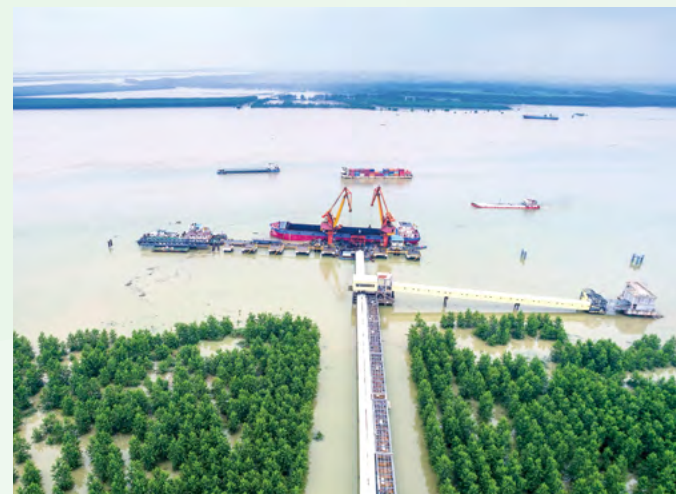
岳阳电厂码头水流湍急
