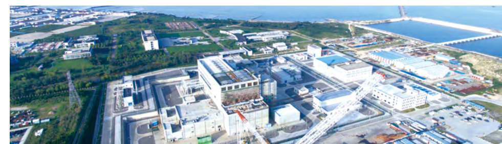
石岛湾高温气冷堆示范工程
