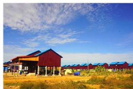
桑河二级水电站移民村
