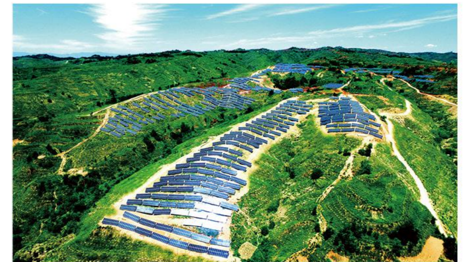
榆社光伏帮扶项目
