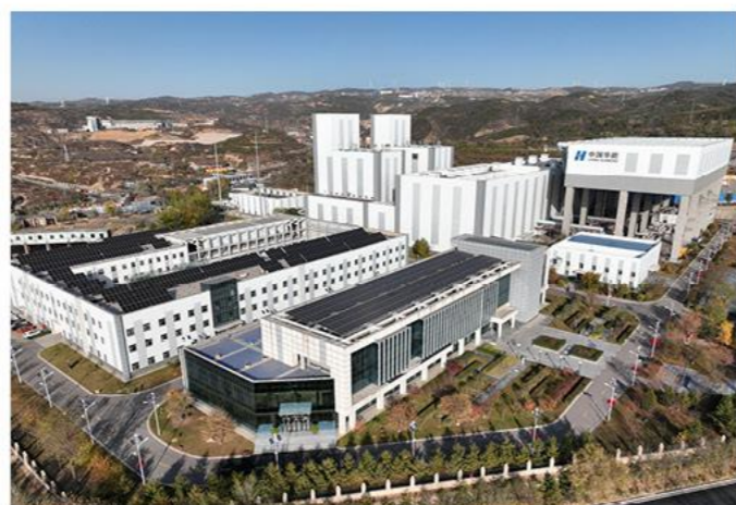
东山燃机电厂屋顶光伏
