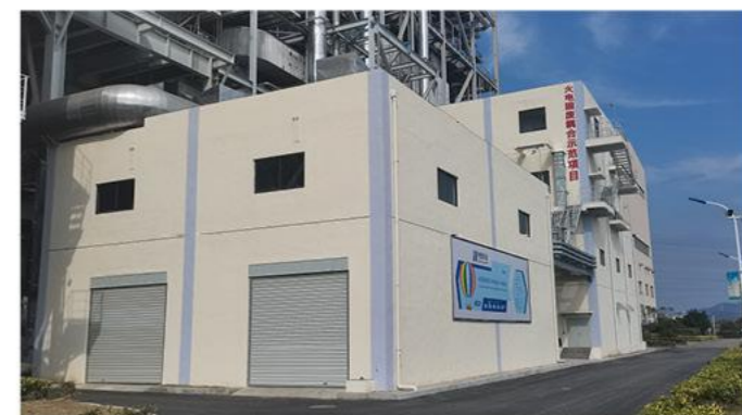
火电固废耦合示范项目
